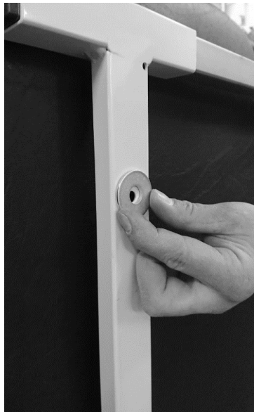
Abbildung 3: Scheiben als Unterlage zur Wandmontage
